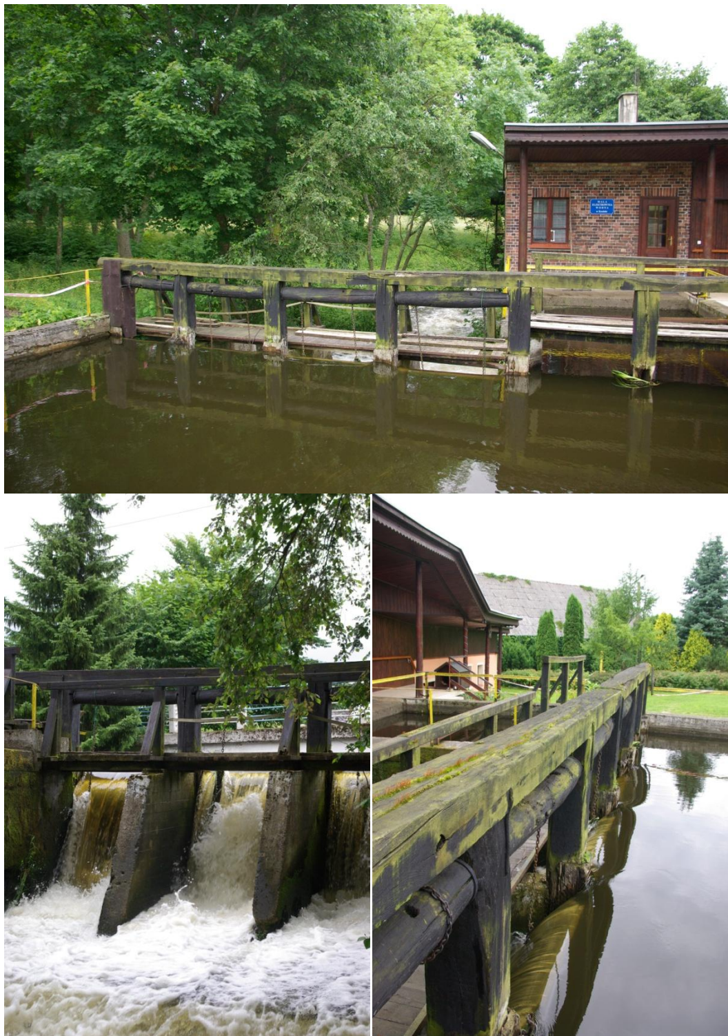
Fot. 7 Widok na istniejący jaz (wydzielenie terenu 2 WS)
