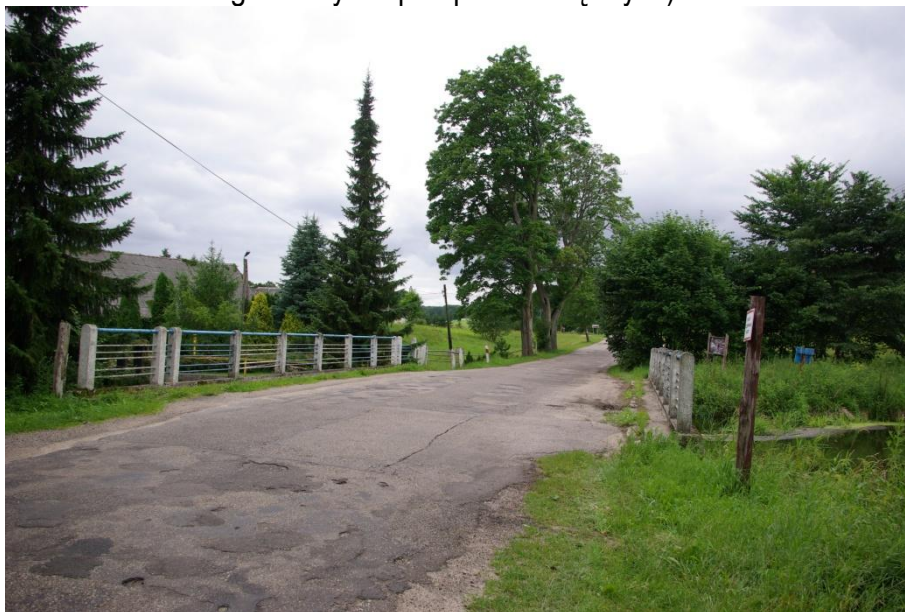
Fot. 6 Widok na most na rzece Bukowinie przed spiętrzeniem na jazie
