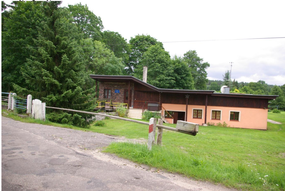
Fot. 2 Widok na istniejącą zabudowę techniczno – mieszkaniową MEW na rzece Bukowinie – teren wydzielenia 1 MN/U projektu planu
