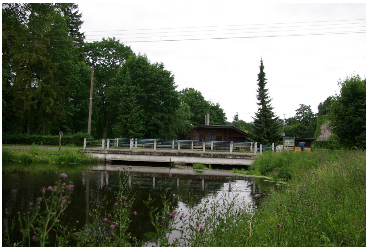
Fot. 3 Widok od strony wschodniej na spiętrzenie rzeki Bukowiny przed jazem
