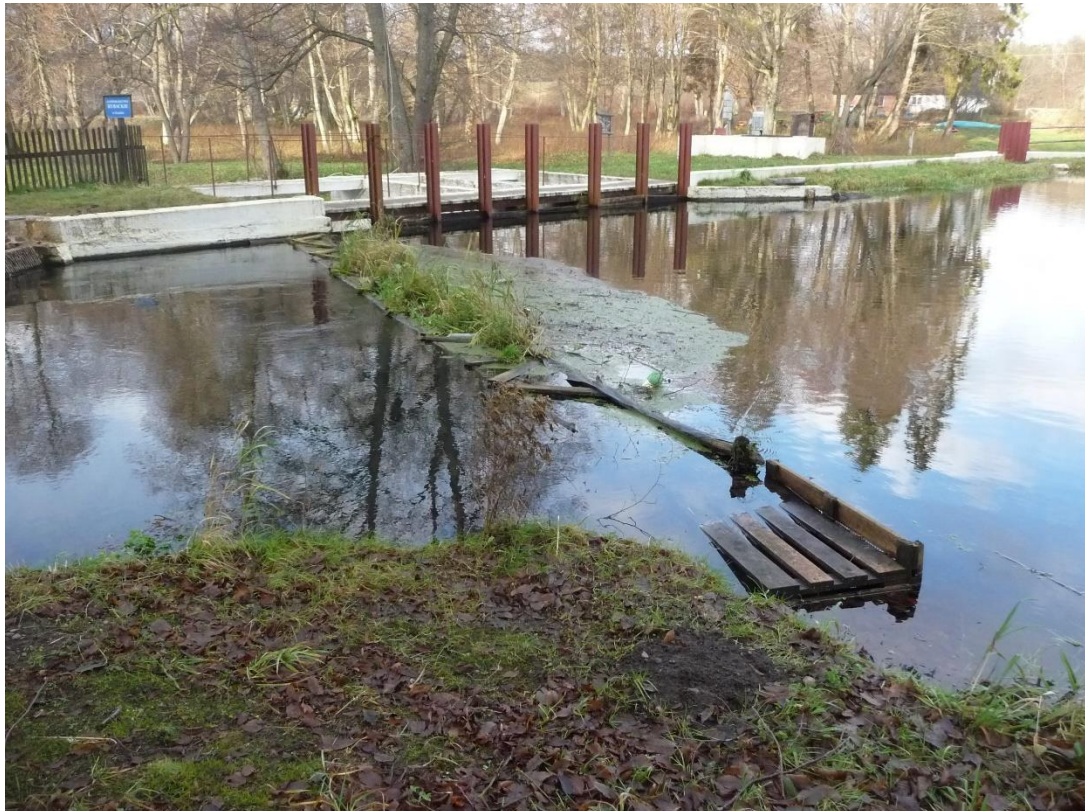
Fot.1. Jaz od strony górnej wody
